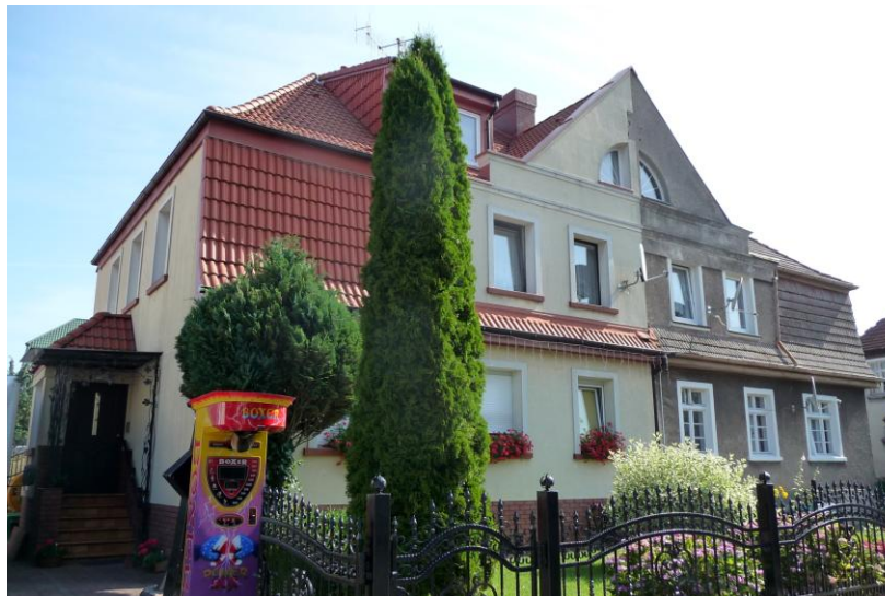
Widok budynku od południowego-zachodu
