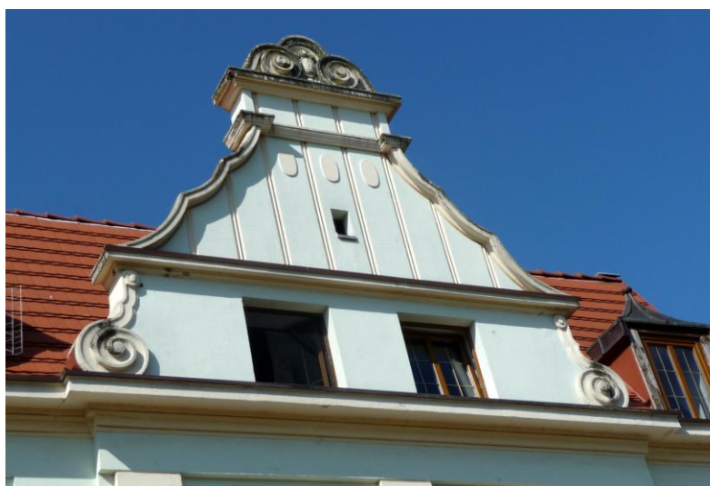
Facjatka na południowej połaci dachu
