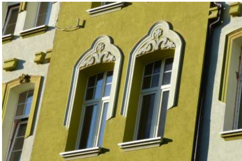
Otwory okienne w elewacji frontowej
