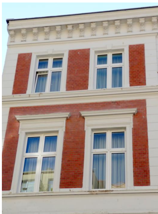
Otwory okienne w elewacji wschodniej
