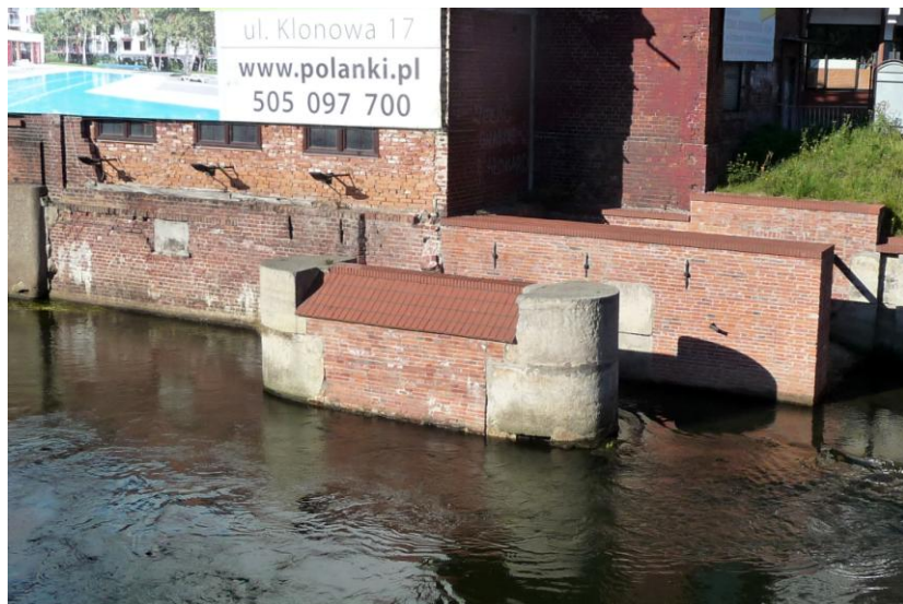
Widok od południowego-zachodu
