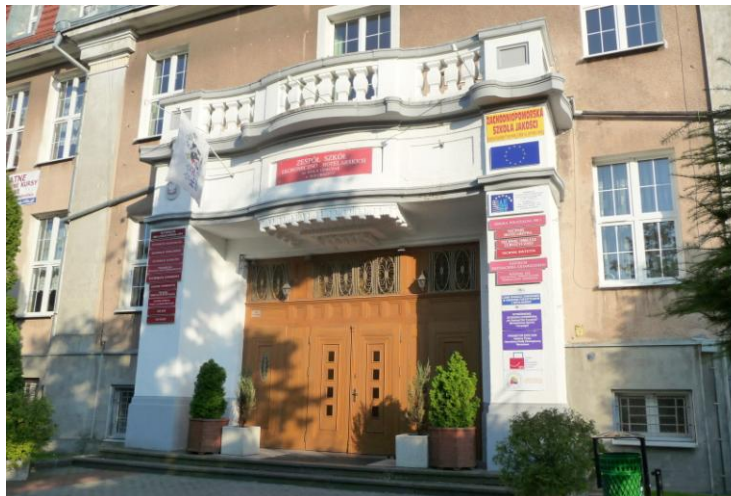
Wejście od ul. Łopuskiego
