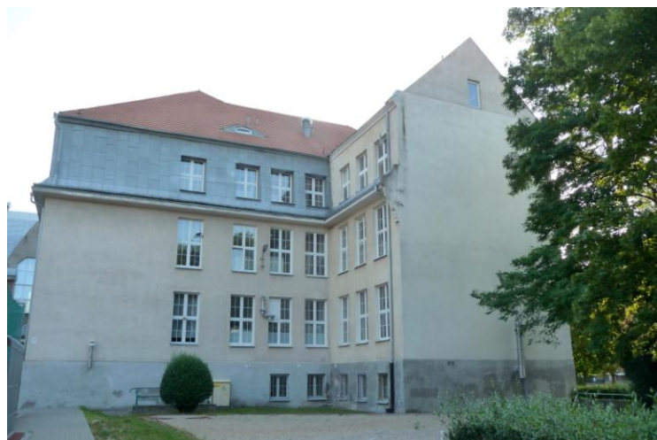
Widok budynku od północnego-wschodu
