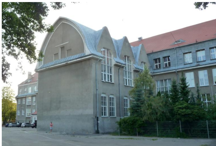
Skrzydło po środku elewacji wsch. widok od wschodu
