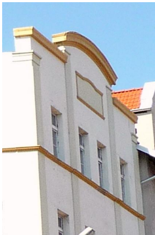
Murek attykowy w elewacji od południowo-wschodniej
