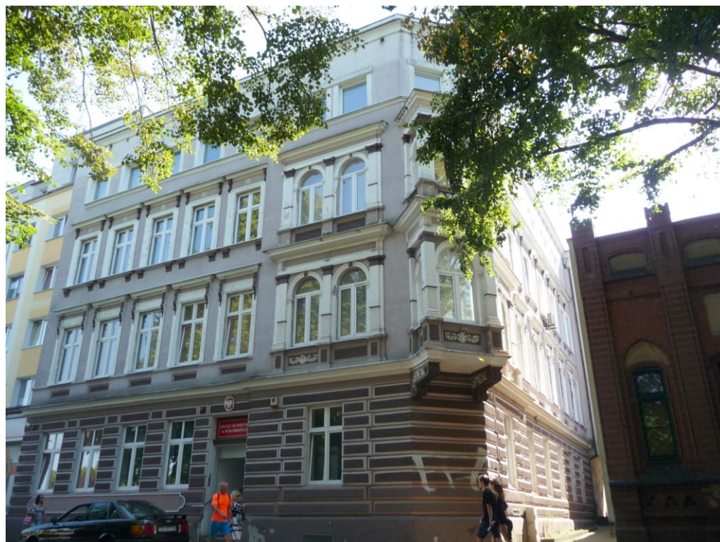
Widok budynku od północy
