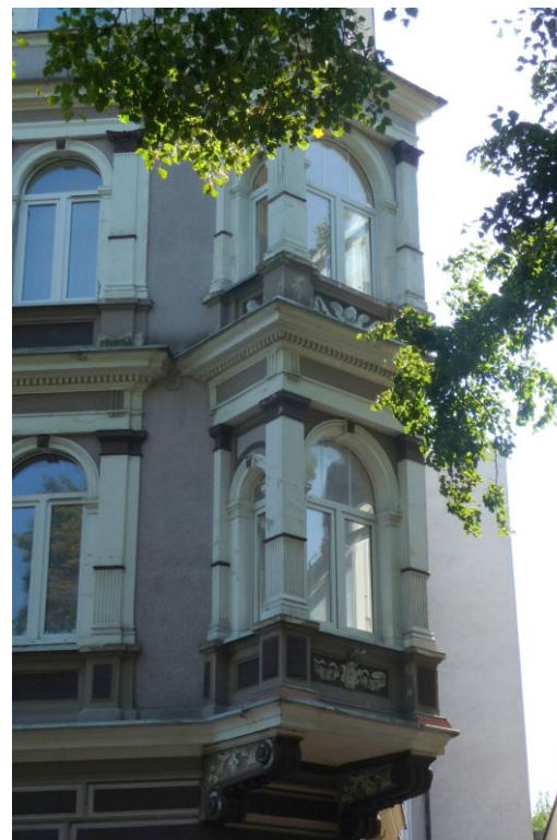
Wykus w północno-zachodnim narożu
