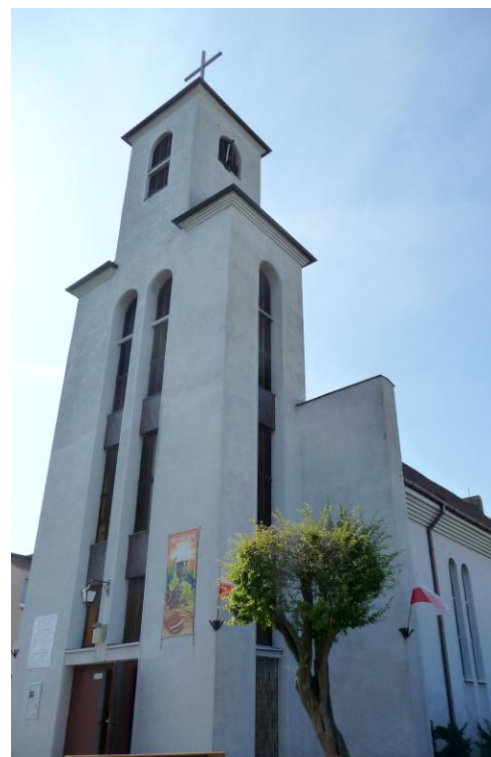
Widok budynku od północy
