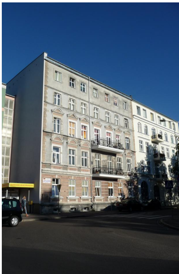
Widok budynku od północno-zachodu
