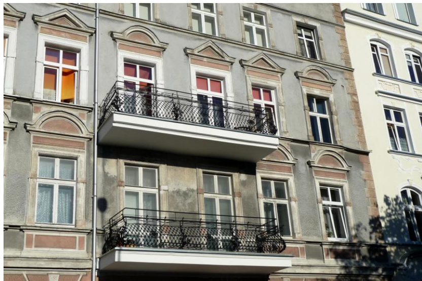
Balkony w elewacji zachodniej
