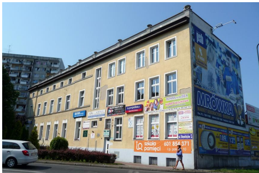
Widok budynku od południowego-wschodu
