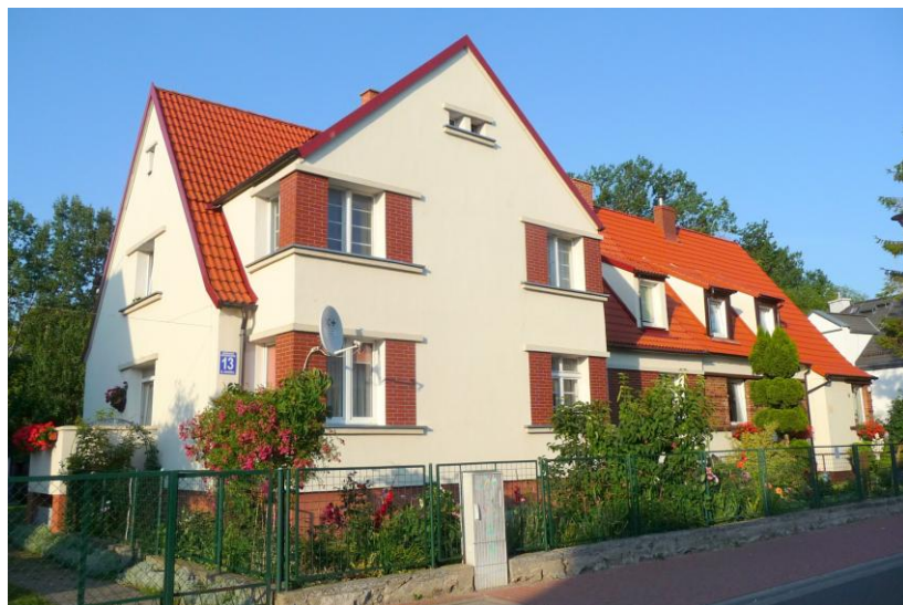
Widok budynku od południowego-wschodu
