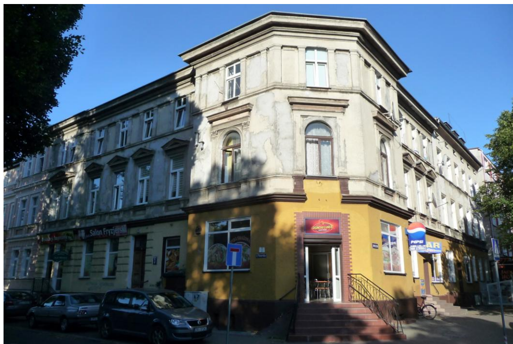
Widok budynku od północnego-zachodu
