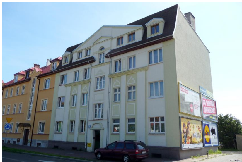
Widok budynku od północnego-zachodu
