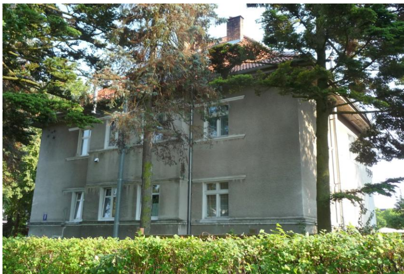
Widok budynku od północnego-zachodu
