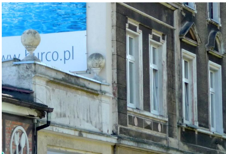
Brama i otwory okienne w elewacji północno-zachodniej
